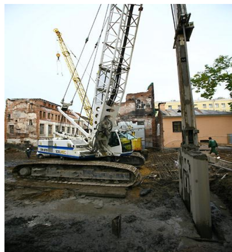
Рис. 1. Двухчелюстной напорный грейфер
