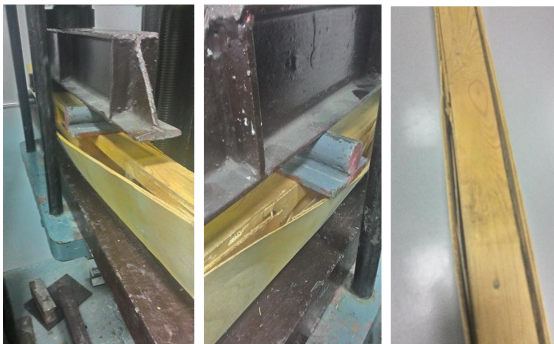
Рис. 4. Характер разрушения образца фанерной клееной балки
